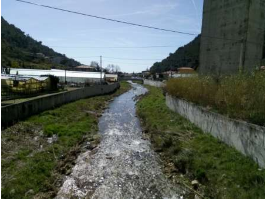
Foto 3 - torrente Verbone a valle della stazione idrometrica di progetto
