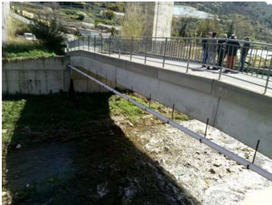
Foto 2 – ponte per installazione della stazione idrometrica sul torrente Verbone
