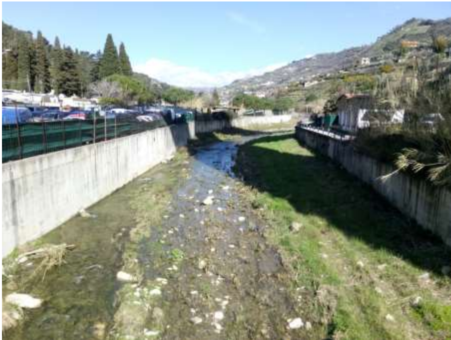
Foto 4 - torrente Verbone a monte della stazione idrometrica di progetto
