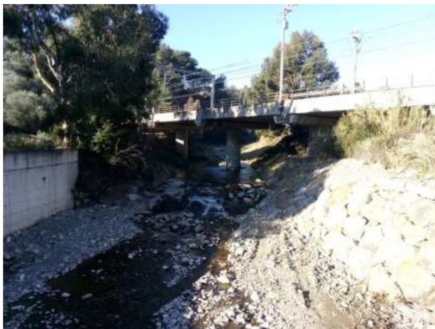
Foto 4 - sito per installazione della stazione idro-pluviometrica sul torrente San Lorenzo
